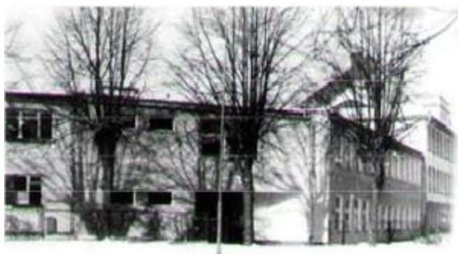
rozbudowa części szkoły od ulicy Traugutta
