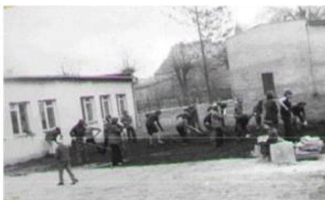
sprzątanie placu pod budowę pawilonu
